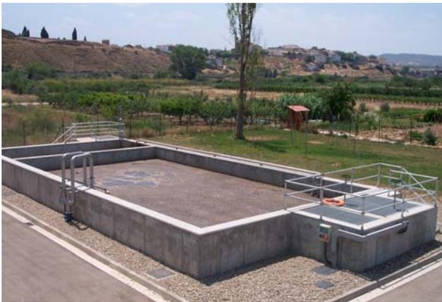
Desde el reactor el agua pasa al decantador secundario, de 9 m de diámetro y 3 m de profundidad en vertedero, donde se separa el agua de la materia en suspensión.
