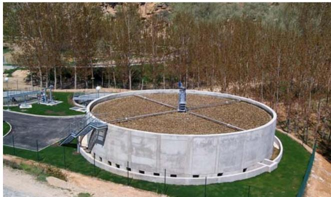
Desde el lecho, el agua pasa al decantador secundario, de 9 m de diámetro y 3 m de profundidad, donde se separa el agua de la materia en suspensión.
