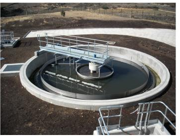
El fango procedente de la purga de los decantadores es bombeado mediante un equipo de 1,3 Kw hasta un espesador de gravedad de poliéster de 2,65 m de diámetro y 3,77 m de altura en vertedero.
