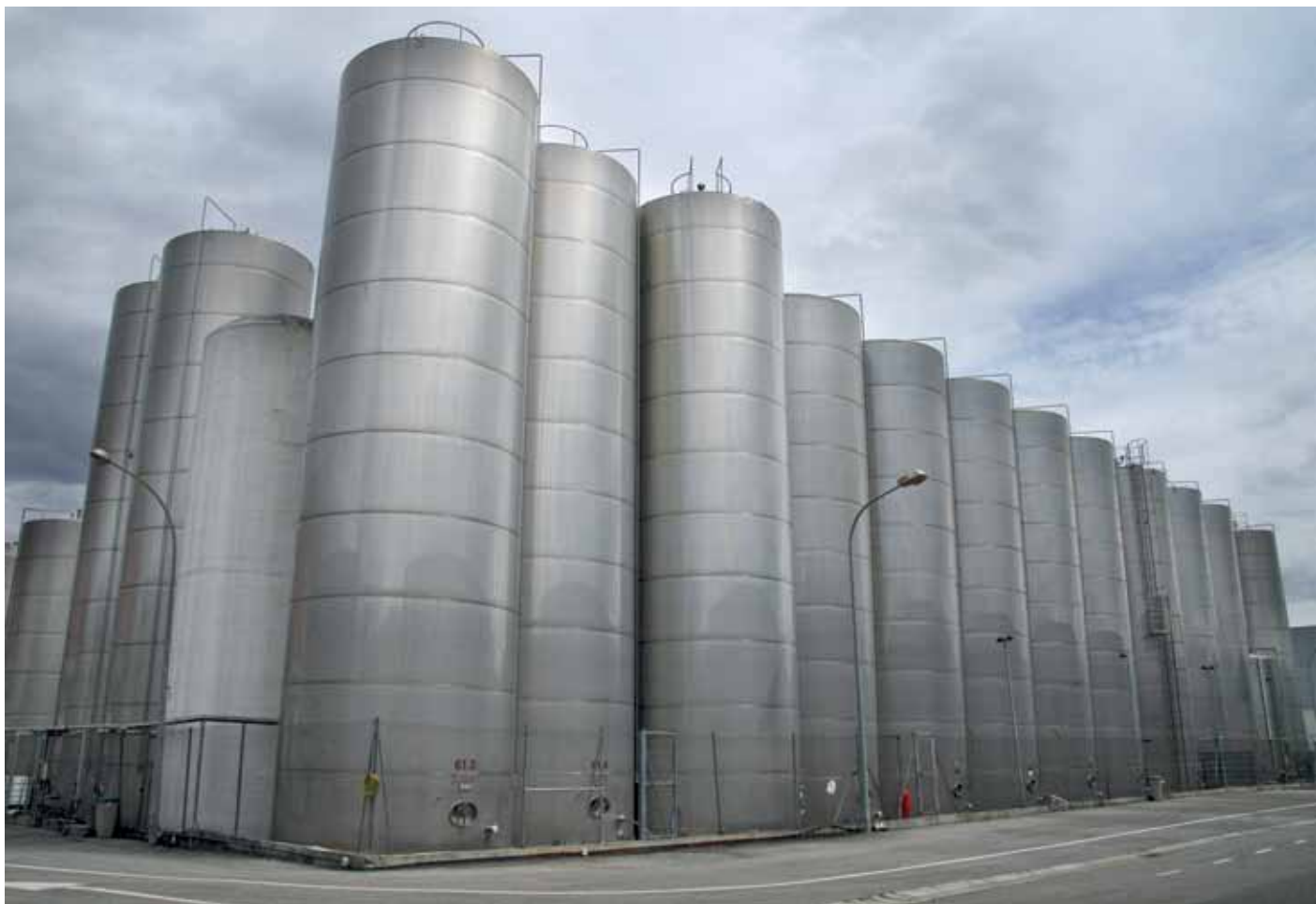
Depósitos de almacenamiento, en el exterior de Vinagerías Riojanas.
